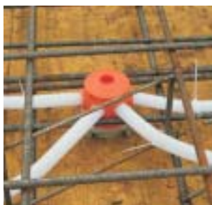
Ejemplo de uso sobre el encofrado horizontal.
