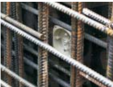
Tapa KBV fijada al encofrado.
