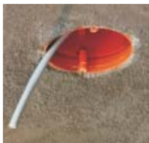
Caja KBT ... con conductor preparado para el montaje del gancho para araña KBP..
