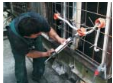
Obtención de los pasos (cemento sellador).
